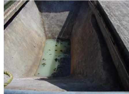
Tanque rectangular de sedimentación simple
