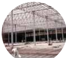
Estructura metálica paralela
