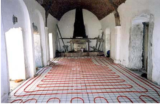
Instalación de mangueras para suelo radiante.
