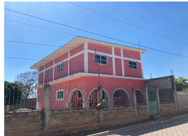
Figura 19. © Susana Delgado (2023) Compilación de arquitectura de remesas (fachadas) en San Martín Totoltepec.
