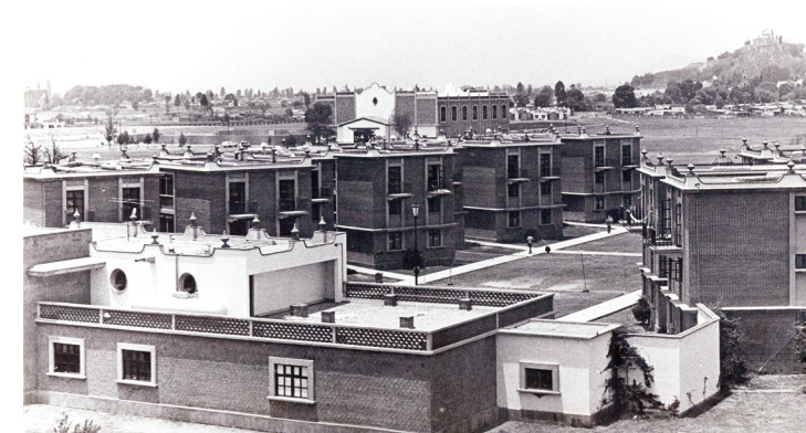
46 Residencias para estudiantes de la UDLAP en proceso de construcción. Archivo UDLAP.
