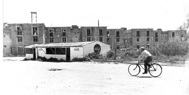
69 Residencias para estudiantes de la UDLAP siendo construidas. Archivo UDLAP.
