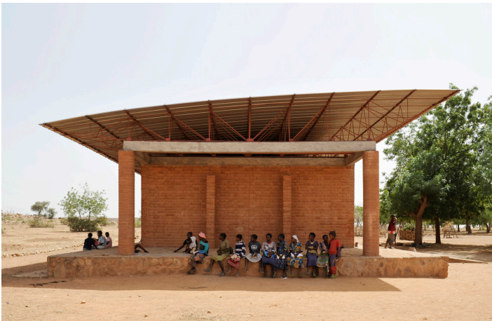
Fig. 21 Niños sentados en el pórtico disfrutando de la sombra producida por la doble techumbre / Escuela Primaria Gando en Burkina Faso por Keré Architecture. Fuente: Siméon Duchoud, Erik Jan Ouwerkerk en Archdaily, 2016.
