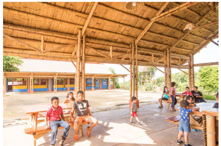
Fig. 24 Patio central y comedor de Crece tu Escuela. Fuente: Lucila Aguilar Arquitectos en Archdaily, 2021.
