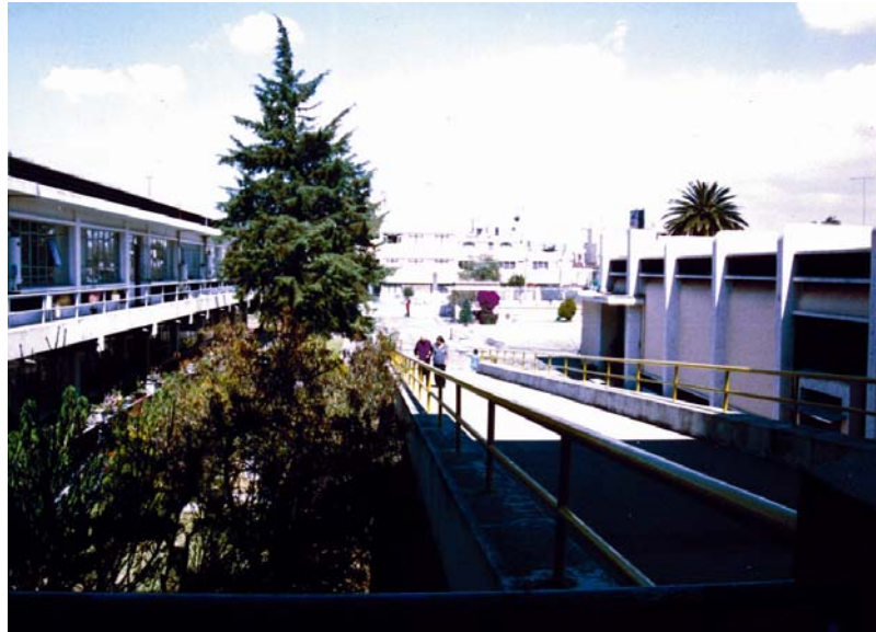
Figura 2. Vista desde el acceso principal al área residencial de la Fundación Gabriel Pastor: a la izquierda el pabellón uno, al centro la rampa principal y a la derecha el auditorio (Fotografía tomada por la autora en diciembre de 2005).
